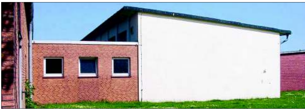
Wird abgerissen: Umkleiden und Gymnastikhalle.
