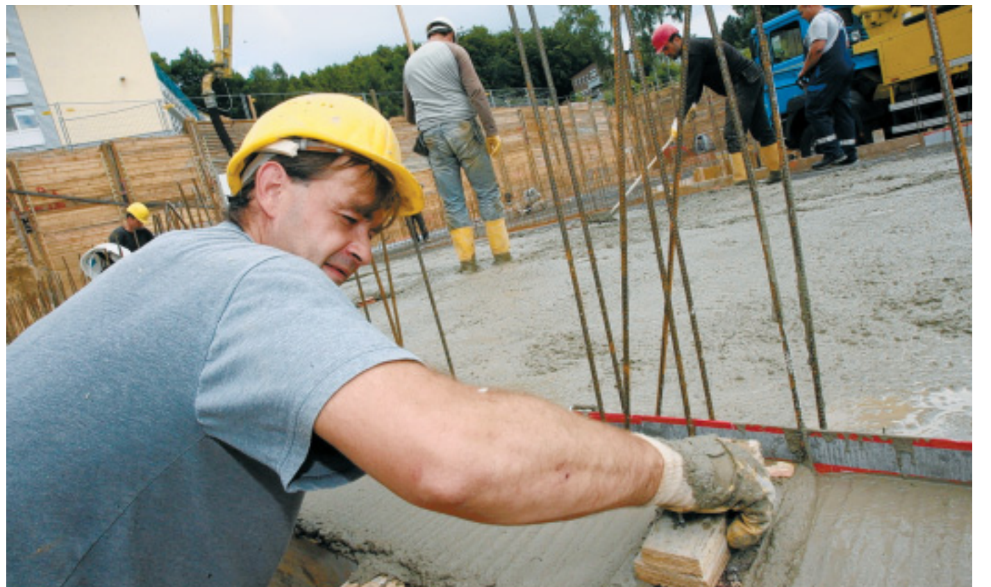
Fundamental: Die Fundamente für die neue Wittekindshofer Förderschule sind gegossen. Seit gestern sind Bauarbeiter wie Alexander Kojic (L.) mit der Bodenplatte beschäftigt, auf der am morgigen Mittwoch die Grundsteinlegung stattfinden wird. FOTO: PETER STEINERT
