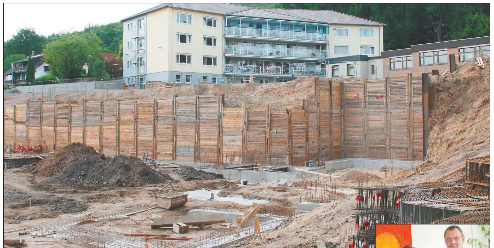
Die neue Förderschule entsteht in unmittelbarer Nachbarschaft zur Kinderheimat (im Hintergrund). Die Baugrube ist abgesichert, und die ersten Fundamente sind bereits zu sehen. Fotos: Marholdt
